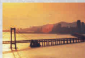
Inspección de puentes
