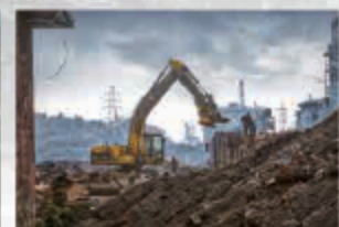
Control de máquinas
